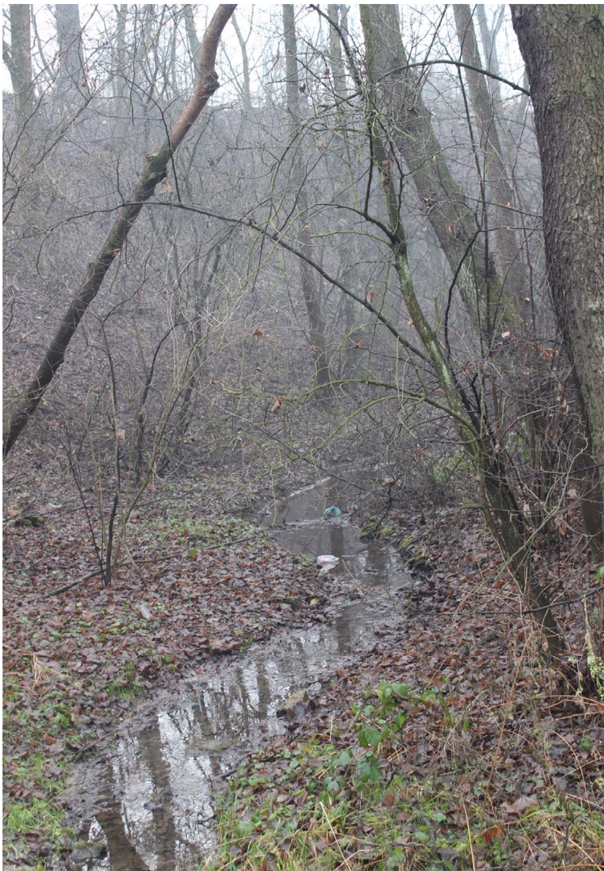
Fot. 18 Ciek wodny doptywający do przepustu w nasypie kolejowych od strony północnej, styczeń 2014 (fot. B. Stawarz)
