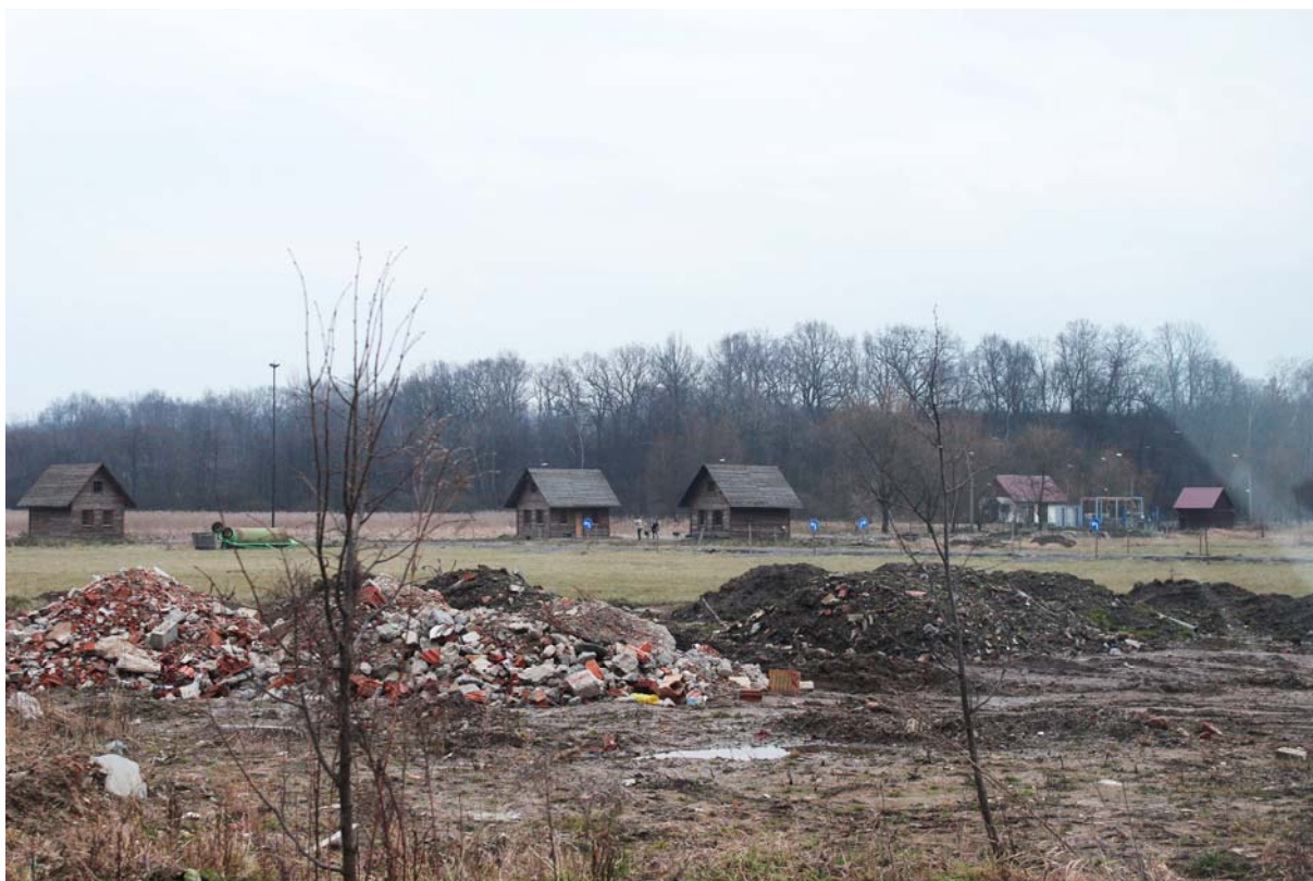
Fot. 6 Zagruzowana i poddawana coraz większym przekształceniom północna część doliny Rudawy, styczeń 2015
