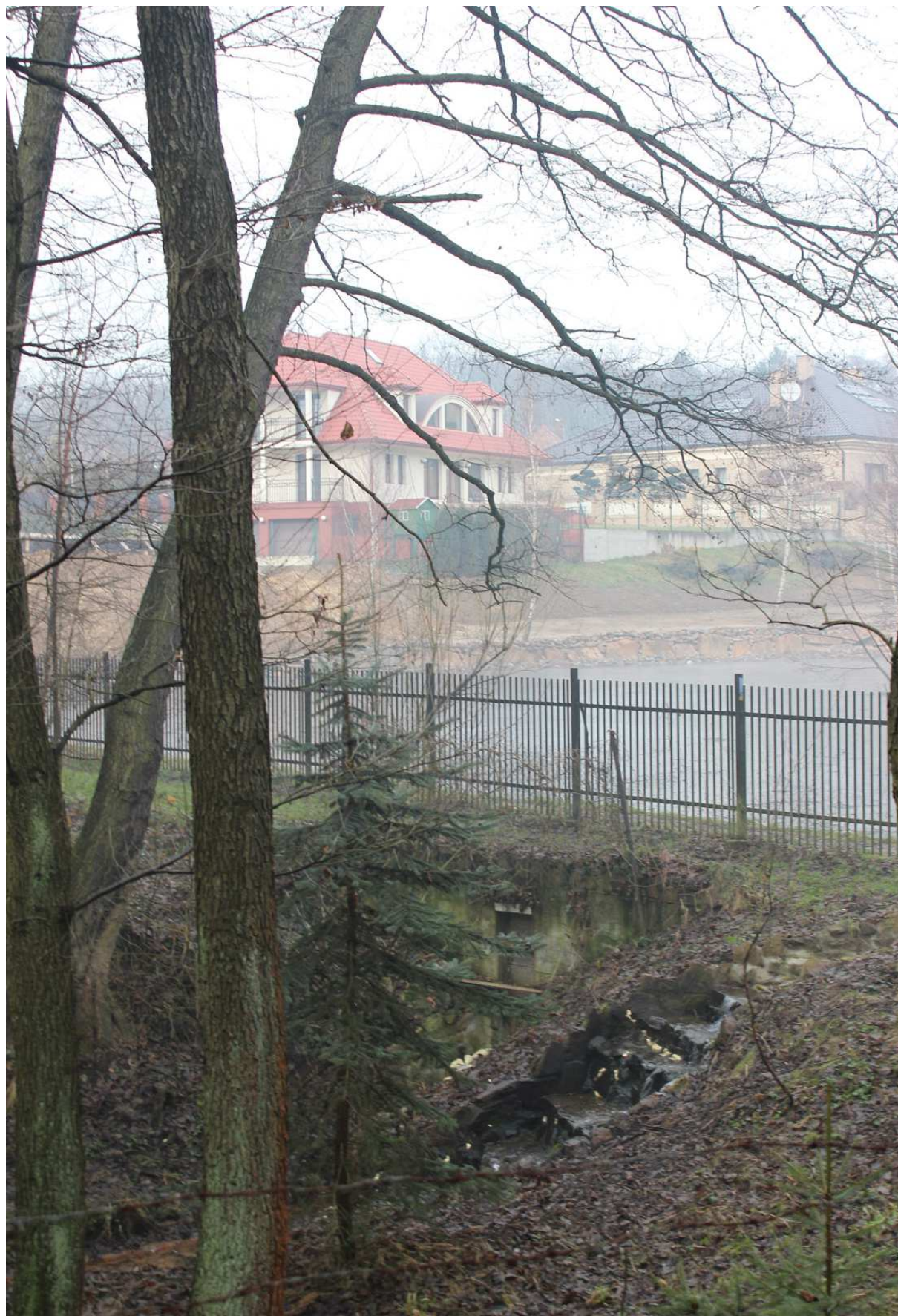
Fot. 19 Jaz oraz przepust z kaskadą przy zachodniej grobli stawu nr 1, styczeń 2014 (fot. B. Stawarz)
