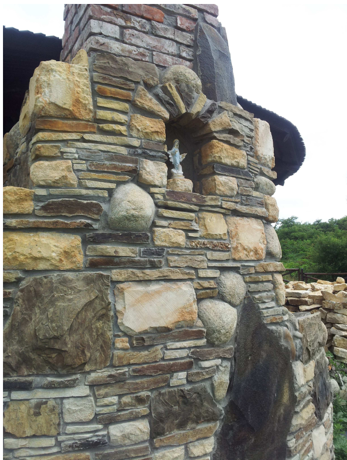
Fot. 28 Kapliczka na polanie od strony Bronowic, czerwiec 2012 (fot. E. Dubiel)
