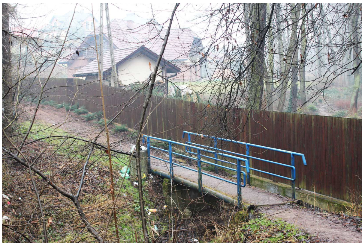
Fot. 1 Kładka piesza oraz ogrodzenie z przepustem w południowo – zachodniej części obszaru, styczeń 2014 (fot. B. Stawarz)
