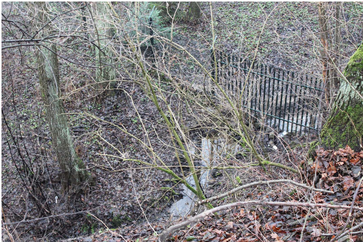
Fot. 3 Ciek odwadniający dno doliny jest poprzegradzany płotami o różnej konstrukcji, styczeń 2014 (fot. B. Stawarz)
